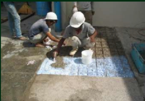
Perbaikan Lantai Pabrik
