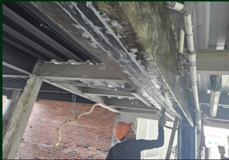
Perkuatan Carbon Plate
