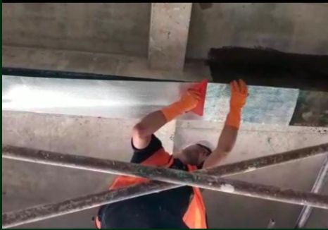
Perkuatan EGlass FRP
